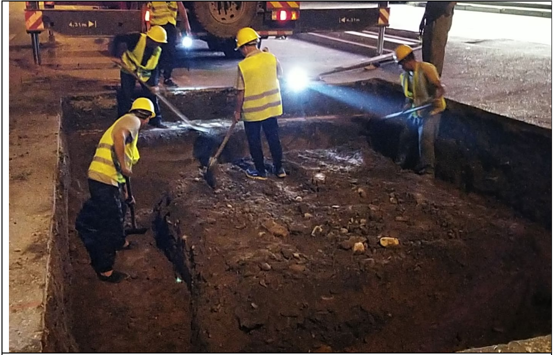
工作井开挖洒水降尘（2021年9月）
