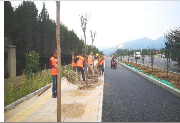
道路沿线绿化区域绿化美化施工照片
