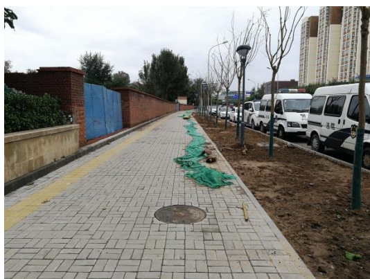
人行步道透水铺装（2021.9）
