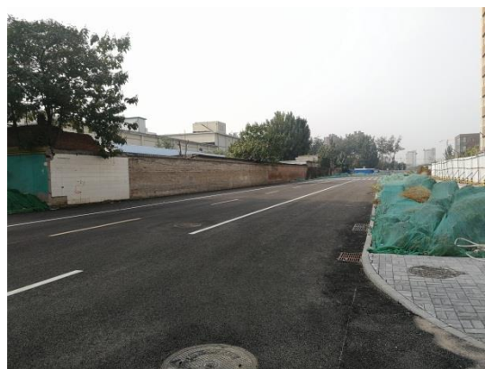
道路工程完工（2019.10）
