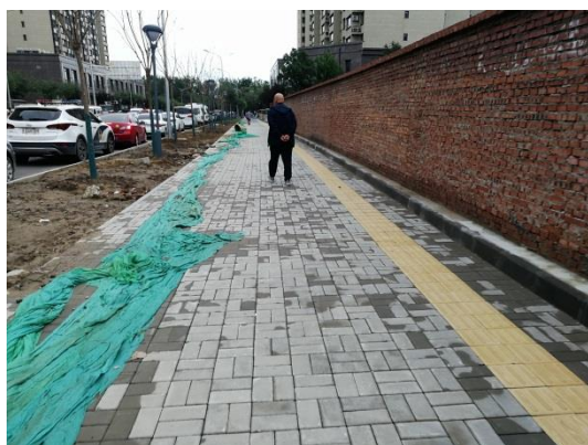
人行步道透水铺装（2021.9）
