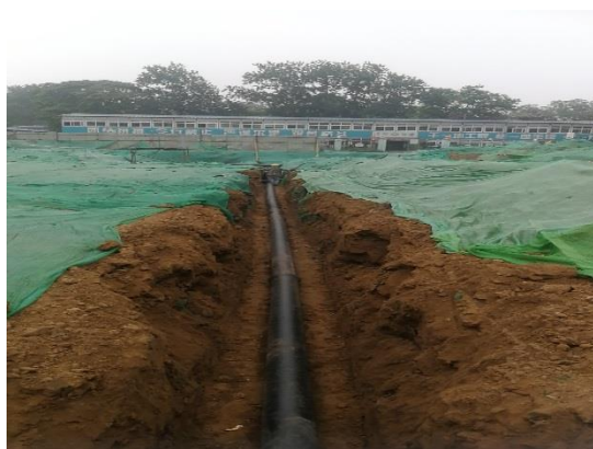
中水管道安装 (2019.4)
