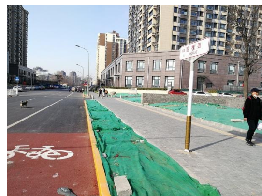
平交道口绿化区域防尘网苫盖 (2021.3)
