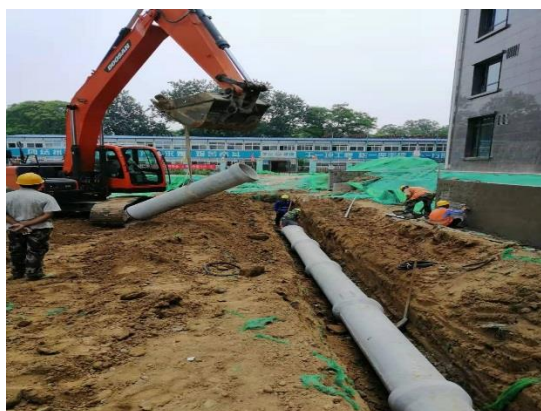
临时排水管道安装 (2019.6)
