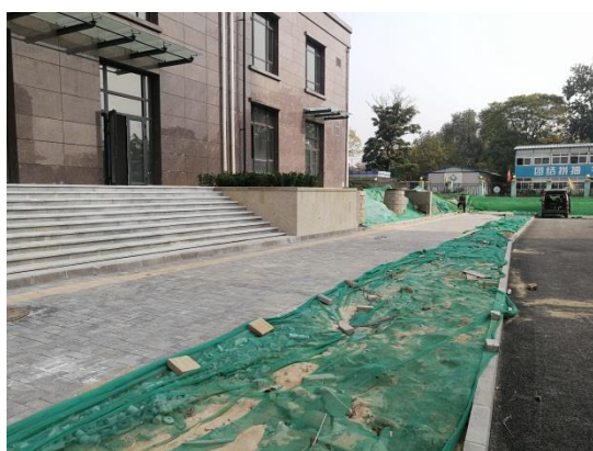
步道透水铺装及绿化带苫盖（2019.10）
