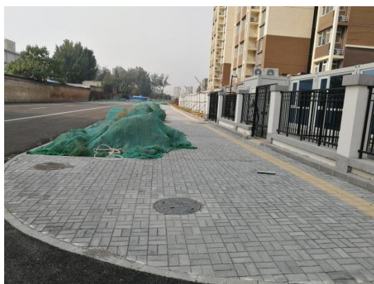
步道透水铺装及绿化带苫盖（2019.10）
