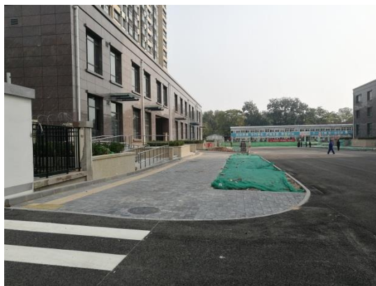
步道透水铺装及绿化带苫盖（2019.10）
