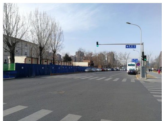
南侧拆迁区域彩钢板拦挡 (2021.3)
