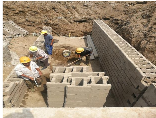
雨水方沟砌筑 (2019.5)
