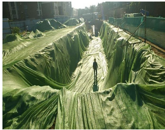
沟槽裸露土方苫盖（2018.11）
