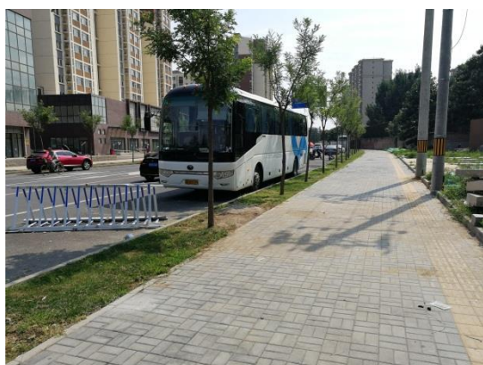
步道透水铺装及绿化带（2020.6）
