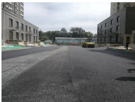
底层油摊铺完成 (2019.8)
