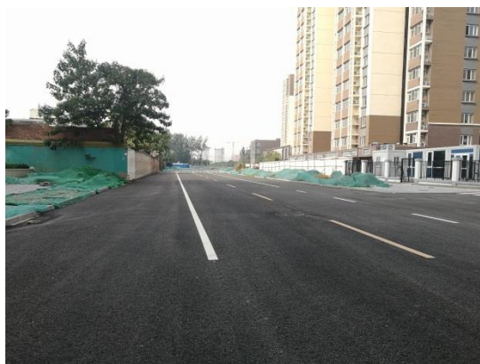
道路工程完工（2019.10）
