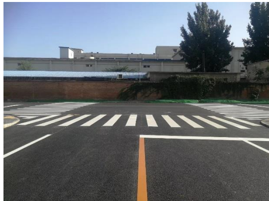
道路标志线划线完成 (2019.8)
