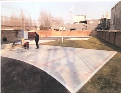
北侧停车场下凹绿地及透水砖铺装 (2022年1月)
