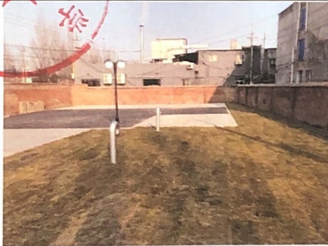
北侧停车场下凹绿地及透水砖铺装 (2022年1月)
