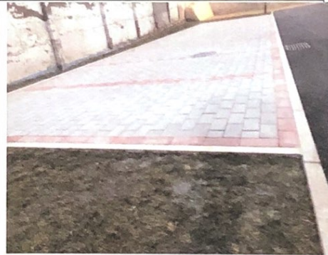
综合实验楼东北侧下凹绿地及透水砖铺装 (2022年1月)
