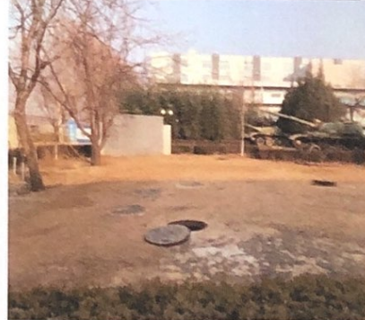
综合实验楼南侧绿地下雨水调蓄池 (2022年1月)
