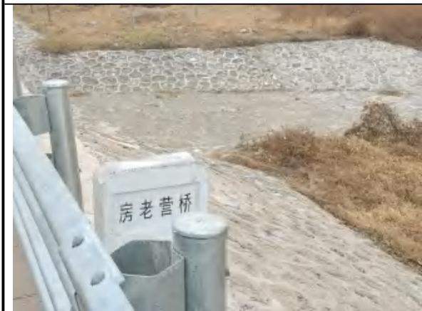
桥区浆砌片石护坡
