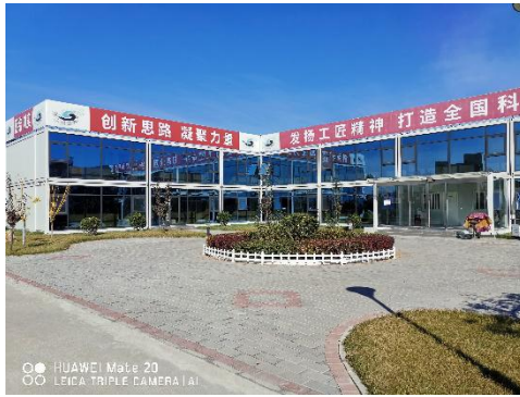
图 1-3 广场透水砖铺装
