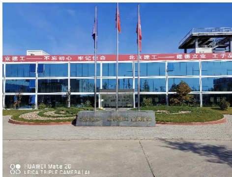
图 1-5 主楼前透水砖铺装
