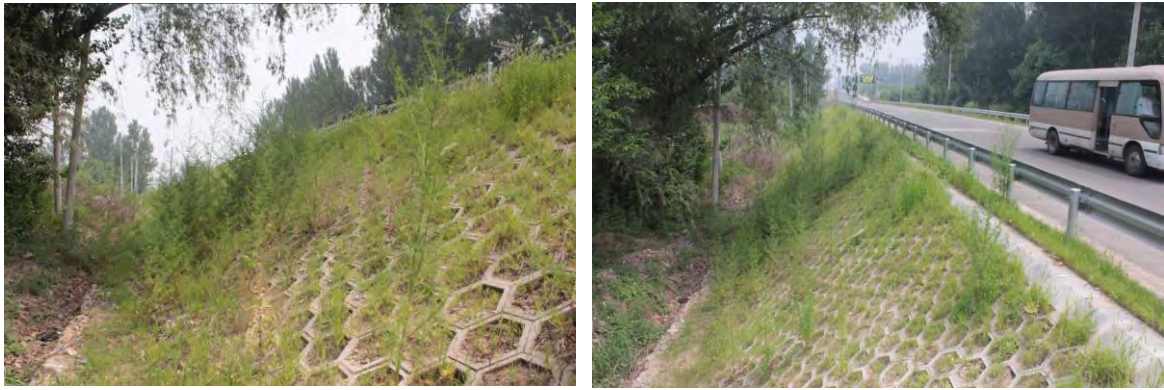
道路工程边坡防护
