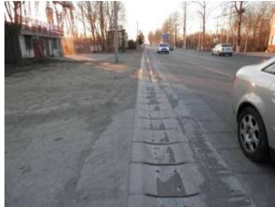
道路盖板方沟
