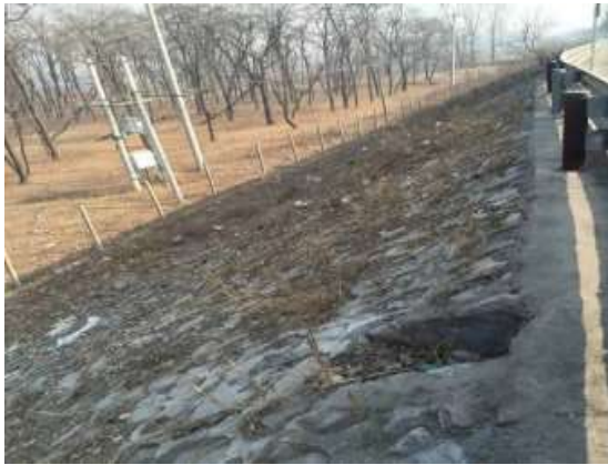
道路边坡综合护坡
