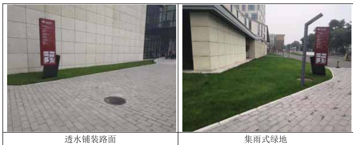
图 3-1 项目区工程措施实施情况
