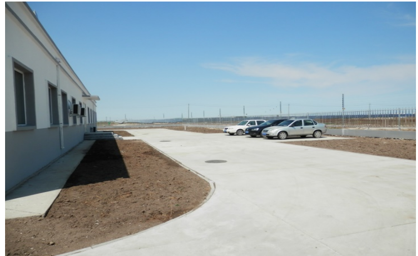
开闭站表土回覆
