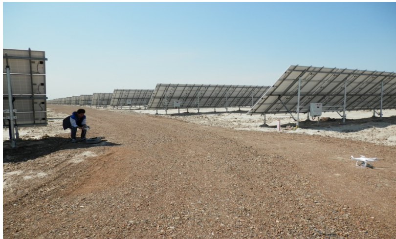
道路区碎石铺路
